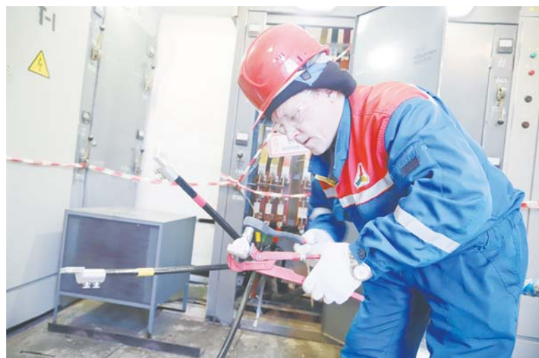
Состязание кабельщиков проходило на действующей подстанции.
