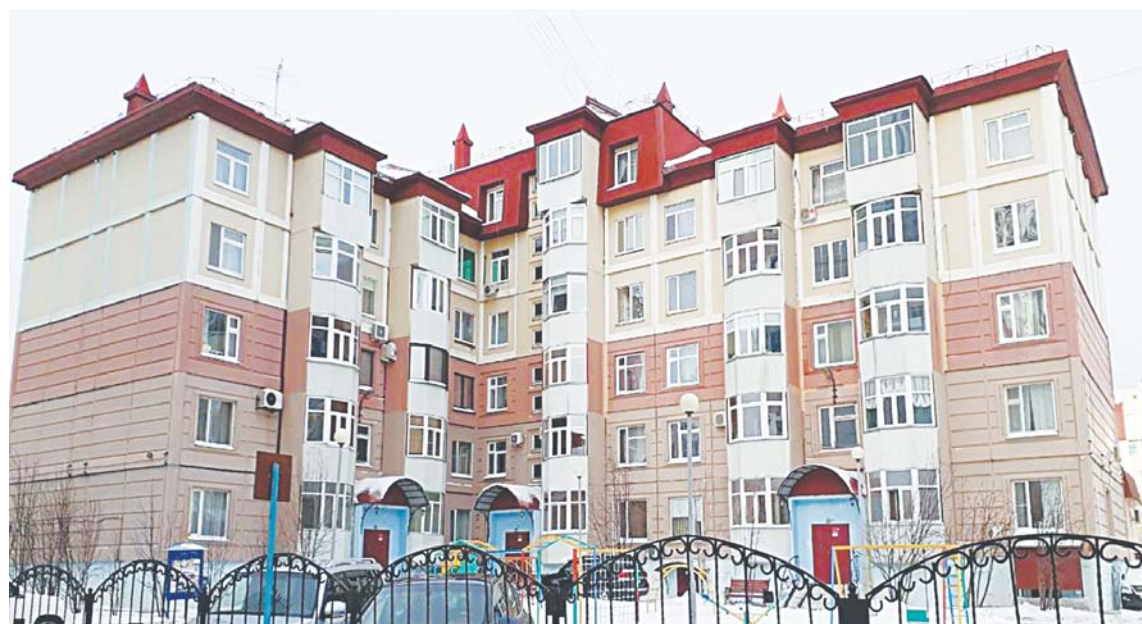
В «умном доме» на улице Ленина, 34а системой учета энергоресурсов довольны и жители, и УК.
