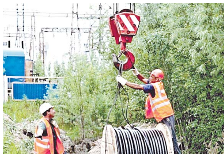
На 26 объектах электроснабжения выполнен капитальный ремонт оборудования, заменено 12,8 км линий электропередач
