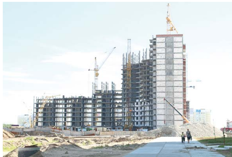
За 2012-2015 годы построено 574,9 тыс. кв. м жилья или 9057 квартир.
